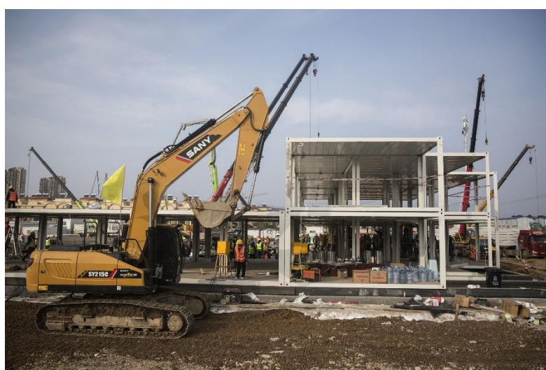
Фиг. 3. Монтаж на обемна клетка (Снимка: Getty Images/Guliver Photos)
