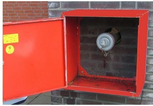
Фиг. 9. Ежегодна проверка на стенните касети и входящия отвор.
