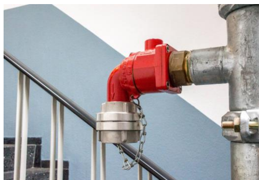
Фиг. 8. Годишна проверка на сухотръбието за наличие на ръжда, пукнатини, вдлъбнатини.
