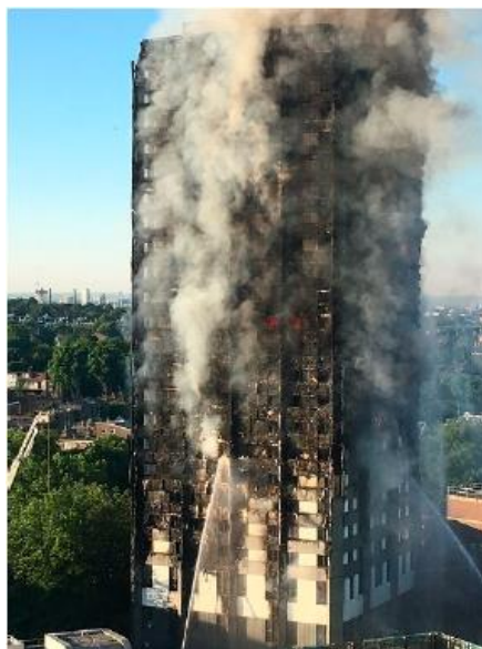
Фиг. 2. Разпространение на пожар по горими елементи на фасадата при невъзможност за подаване на огнегасителни вещества
