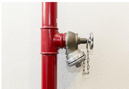
Фиг. 8. Годишна проверка на сухотръбието за наличие на ръжда, пукнатини, вдлъбнатини.
