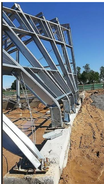
Рис 1. Потеря устойчивости конструкции
