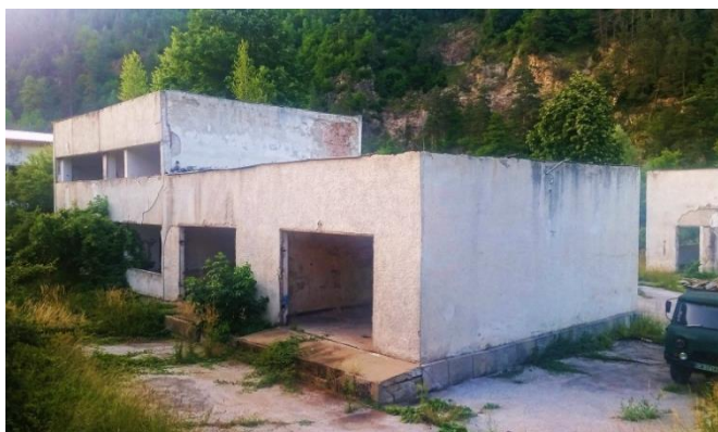
Преди реконструкция (41°30'27.3"N 24°43'47.5"E)
