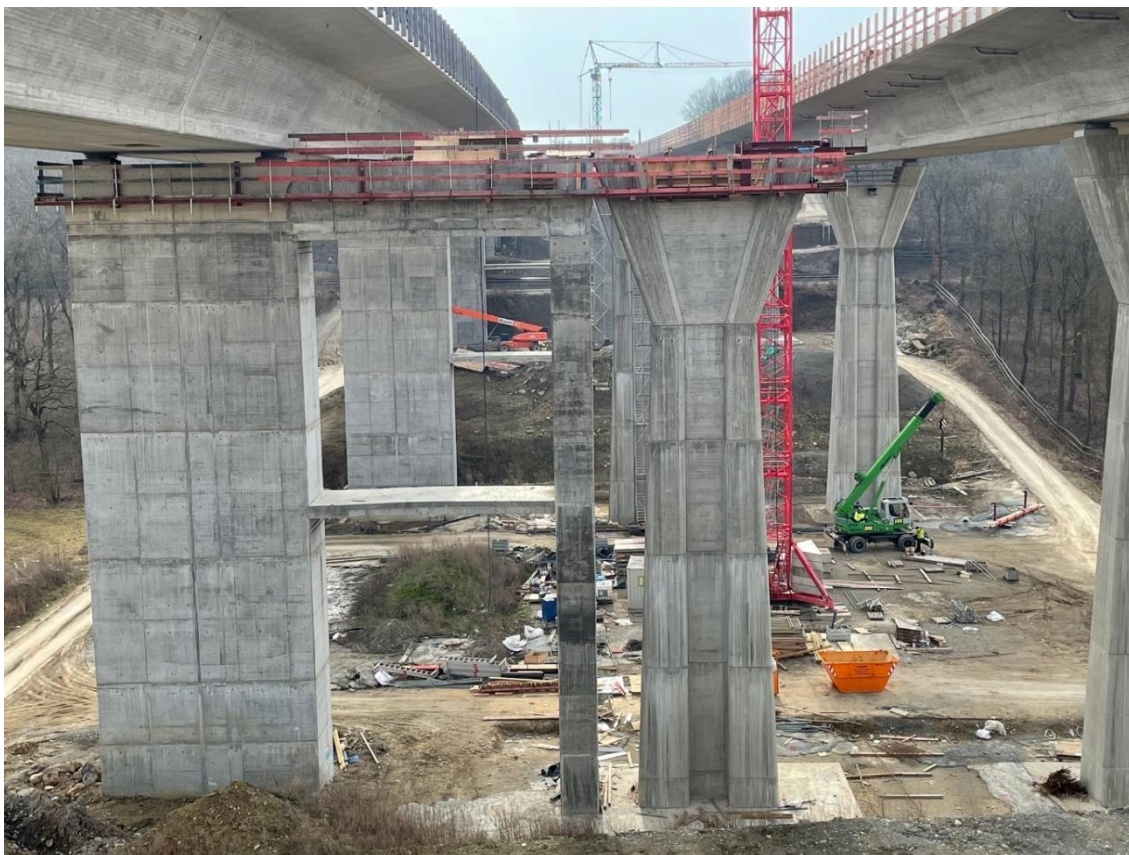
Фиг. 4. Снимка от строителната площадка на стоманобетонната рамка
