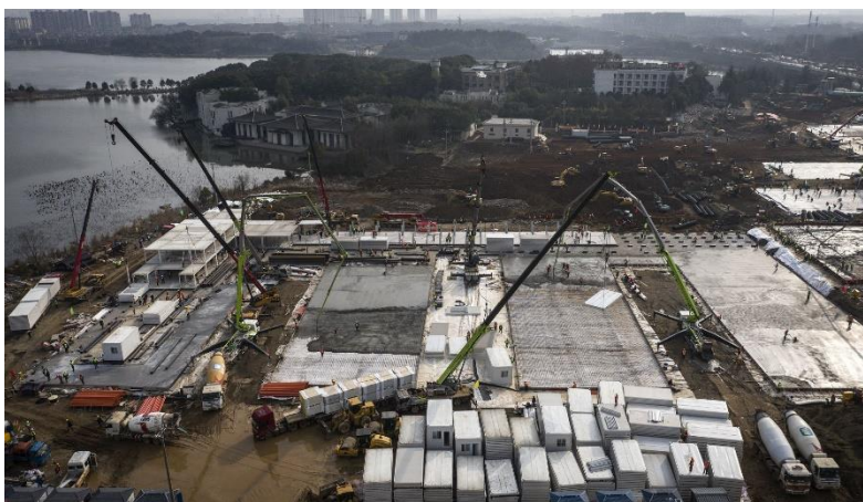
Фиг. 2. Строителство със сглобяеми обемни клетки на болници в гр. Ухан, Китай (Снимка: Getty Images/Guliver Photos)
