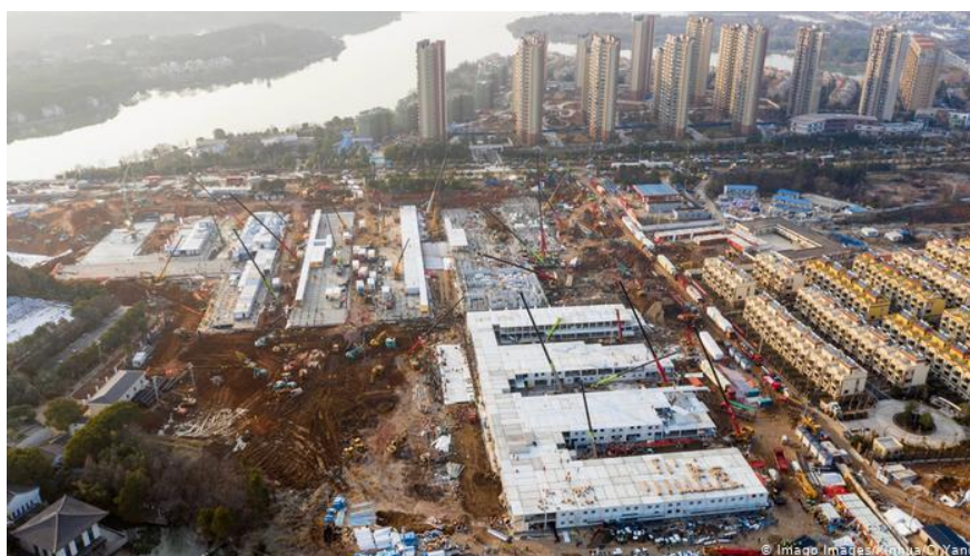
Фиг. 1. Строителство със сглобяеми обемни клетки на болници в гр. Ухан, Китай (Снимка: С. Yang)
