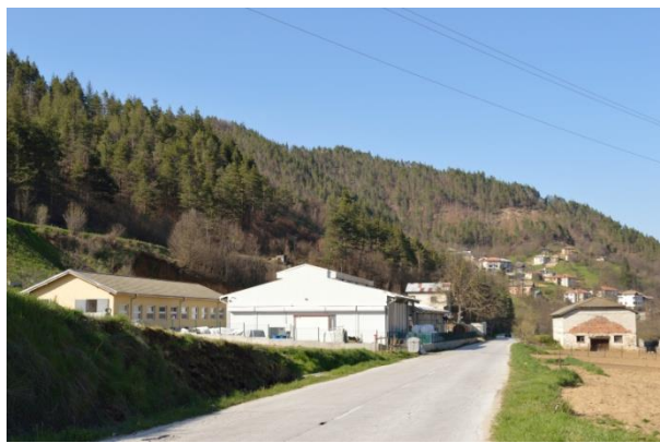
След реконструкция (41°28'25.1"N 24°49'33.3"E)
