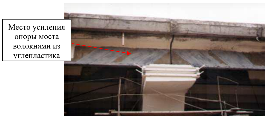
Рис. 2. Иллюстрация схемы усиления моста через реку Киржач
