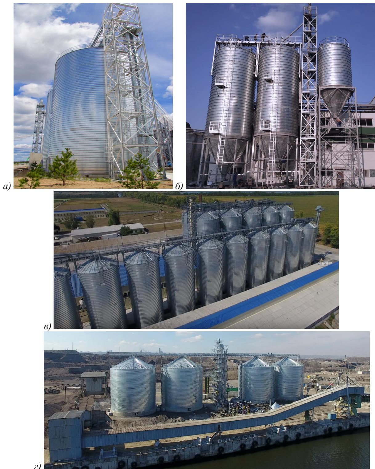
Рис. 7 – Спирально-фальцевые силосы, построенные на территории Украины: а) - ТОВ "Коростеньський Завод МДФ", г. Коростень, 2017г., б) – «Криворожський МЗ», г. Кривий Ріг, 2019г., в) - ТОВ «Рост-Агро» Глобинський р-н, 2017г., з) - г. Каменське, 2019 г.
