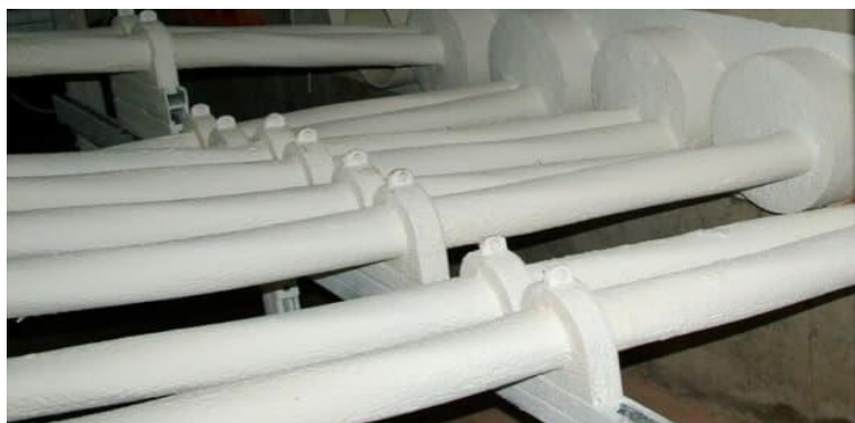
Фиг.4.Електрически кабели с огнеустойчиво покритие
