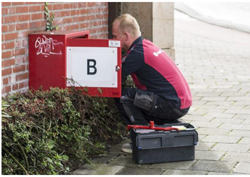
Фиг. 9. Ежегодна проверка на стенните касети и входящия отвор.
