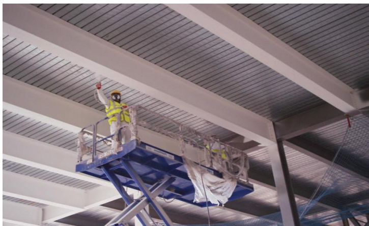
Фиг.2. Полагане на огнезащитно покритие
